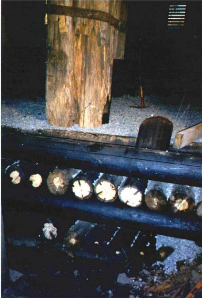
Abbildung 11: Fundamenterneuerung des Sinkhammers, 1989
