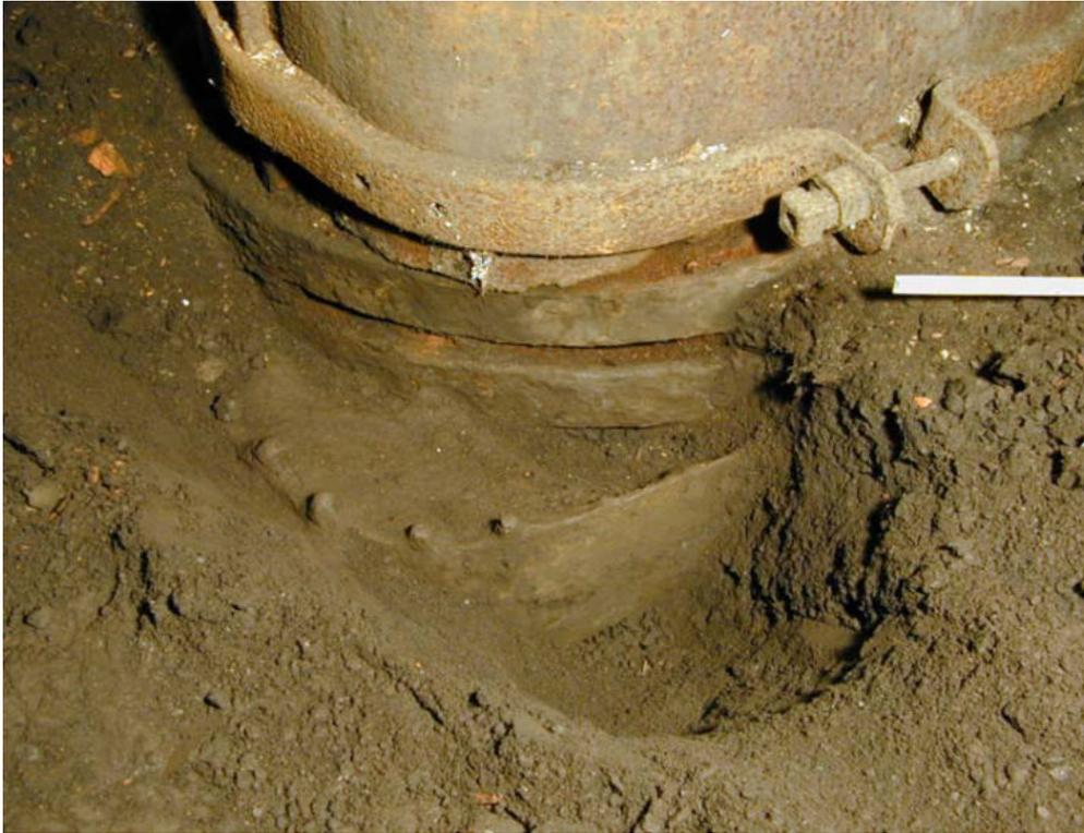
Abbildung 12: Freigelegter Teilbereich des Amboßfundamentes
