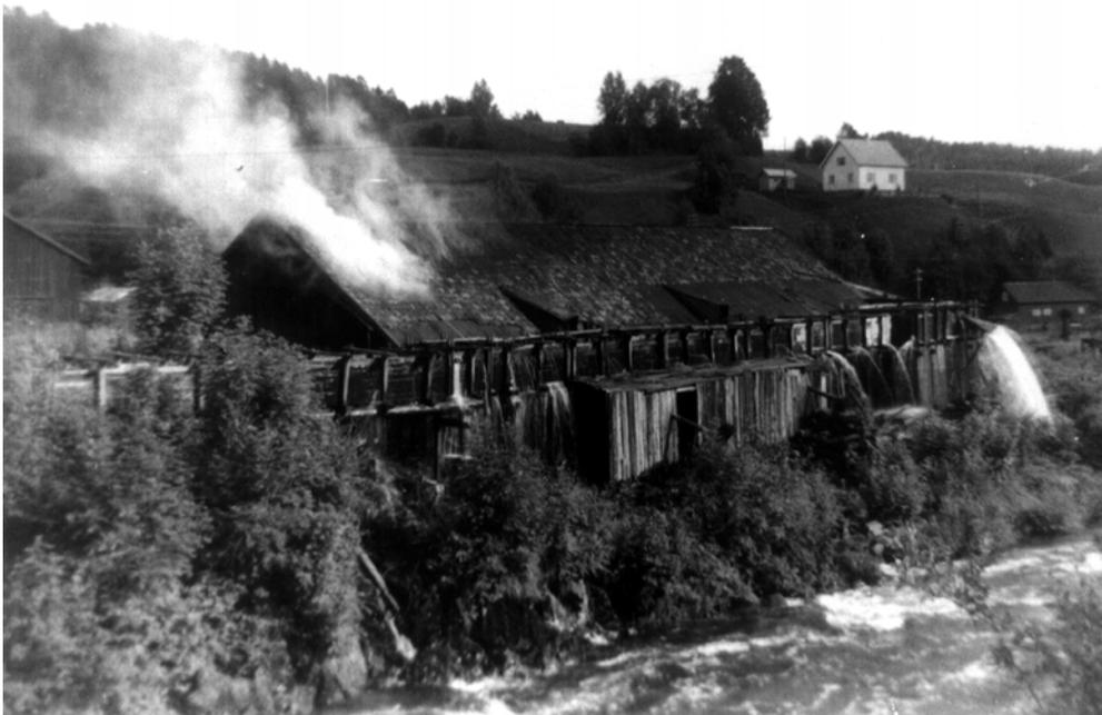
Abbildung 47: Hammergebäude 1950iger Jahre, Rauch kann durch das Dach entweichen, Foto: Technik Museum Norwegen.
